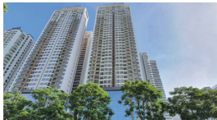
Dự án N01-T1 Ngoại Giao Đoàn - Mitsubishi
