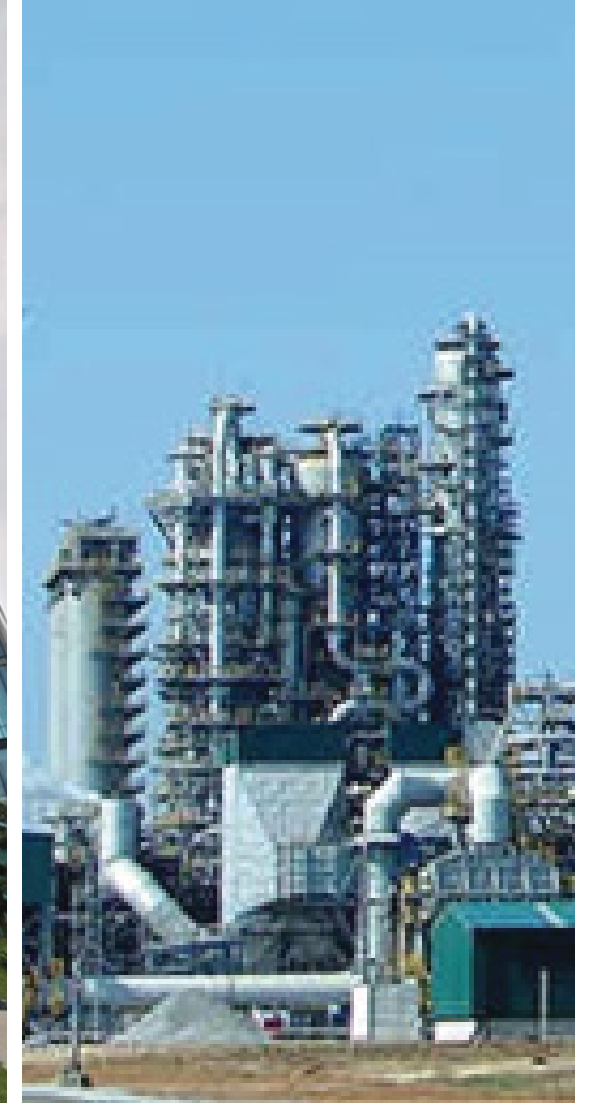
Dự án Nhà máy nhiệt điện Miền Trung
